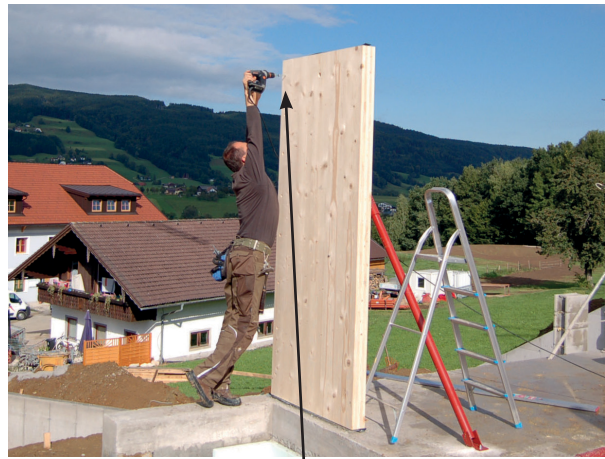
Verschraubung der Eckverbindung
