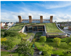
The GSK - klimaneutrales Labor, Nottingham | Großbritannien
