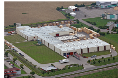
Binderholz Burgbernheim GmbH Brettsperrholzwerk, Burgbernheim | D
