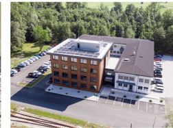
binderholz Bürogebäude TimberBrain, Hallein | Österreich
